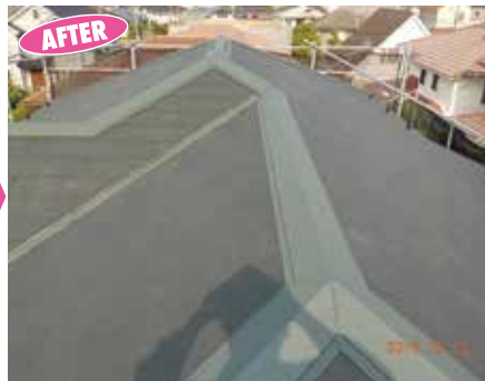
カラーベスト葺替 専門の職人が手際良く葺替ます。
